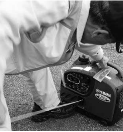
①資機材の点検と試運転
