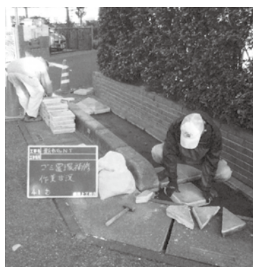
No.47の修理中
