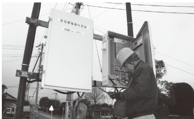
中継器・電源設備の取替工事
