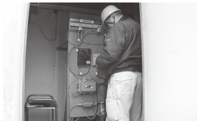
中継器・電源設備の取替工事
