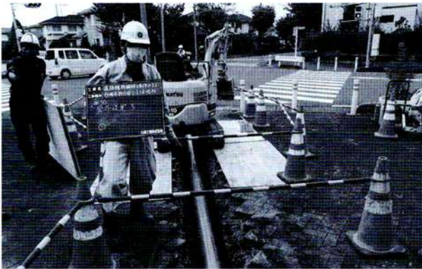
通学路の補修工事
